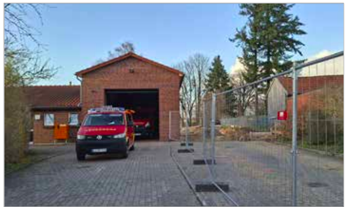
Der Anbau am Feuerwehrhaus Wendhausen startet endlich. Hier wird die Fahrzeughalle um einen weiteren Stellplatz erweitert, die Sanitärräume saniert und ein Jugendraum angebaut. Kosten: 800.000 Euro
